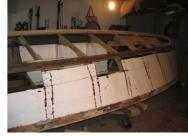
une qualité top l'année 1950). Donc nous choisissons le renforcement par l'insertion d'un flipot dans une rainure faite à la défonceuse. Le collage PU et le serrage doivent se faire avec soin.
